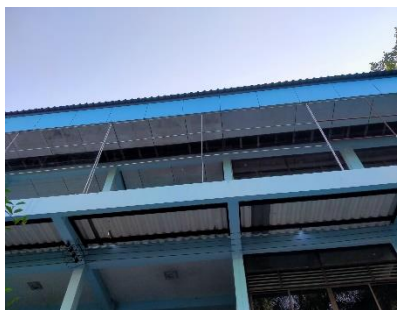
ปรับปรุงซ่อมหลังคา อาคาร 3 อันเกิดจากภัยพิบัติวาตภัย
